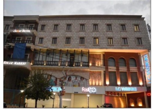
الشكل 14 : مبنى كوكك مول 2015 يقع في شارع مولوي استخدام الحجر الابيض والطابوق لتغليف المبنى (المصدر : الباحثة)
