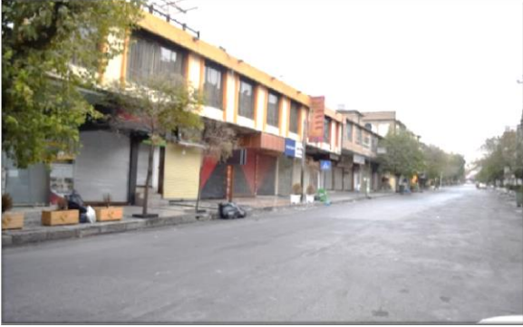
الشكل 21 : مبنى تجاري في احدى شوارع المختارة بمركز المدينة ، استخدام اليكوبوند في تغليف المبنى (المصدر : الباحثة)
